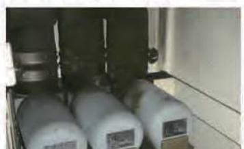
高圧キャビネット内部に施設されたモールド形ジスコンの焼損
