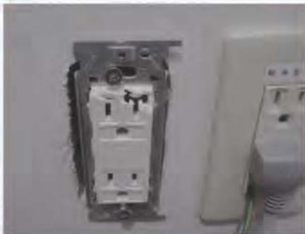
コンセントが机や機器類により押し付けられて破損
