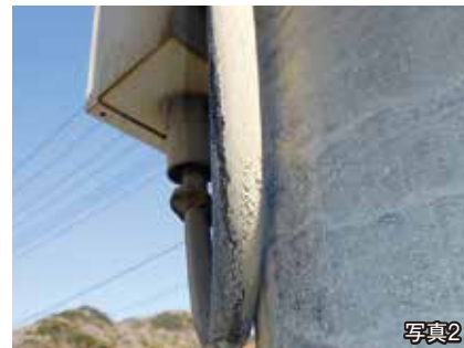
潮によって真っ白になった1号柱(写真1)と制御線(写真2)
